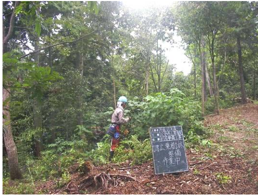
広葉樹エリアの整備中
