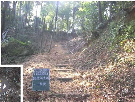
整備した歩道と案内看板
